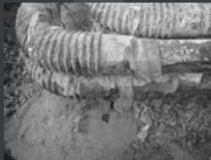
Auftretende Fehler, die ein Sinken des Isolationswertes im Rohr zur Folge haben, werden von der Anlage automatisch geortet.
